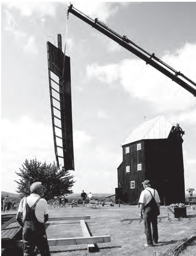
Demontage der Flügel der Kottmarsdorfer Mühle im September. Dank vieler Spenden sind die Weichen für eine baldige Reparatur gestellt. Foto: Verein
